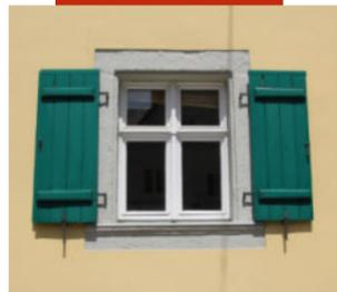
*Fenster mit dunklem Rahmen dagegen lassen die Öffnungen als Löcher erscheinen und akzentuieren damit die Öffnungen, anstatt diese mit der Fassade zu verbinden. Grundsätzlich sind Kunststoff- und Metallfenster bei Baudenkmalen nicht zulässig.*
