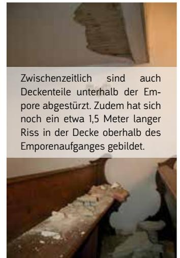
Zwischenzeitlich sind auch Deckenteile unterhalb der Empore abgestürzt. Zudem hat sich noch ein etwa 1,5 Meter langer Riss in der Decke oberhalb des Emporenaufganges gebildet.
