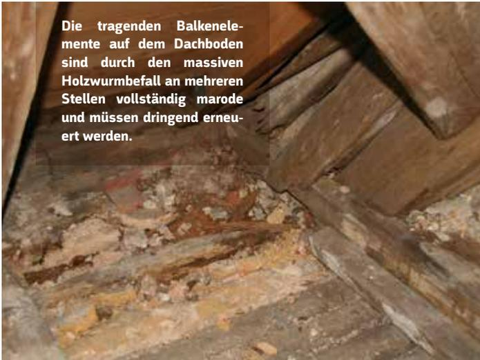
Die tragenden Balkenelemente auf dem Dachboden sind durch den massiven Holzwurmbefall an mehreren Stellen vollständig marode und müssen dringend erneuert werden.
