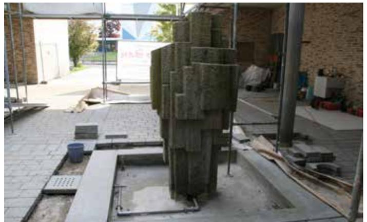
Im Vorhof mit dem Brunnen werden Bodenplatten ausgetauscht und die Betonpfeiler saniert. Im Kirchenschiff wurde das große Kreuz neben dem Altar gegen Verschmutzungen dick eingepackt. Der Lichtschacht zum Taufbecken wurde überarbeitet.
