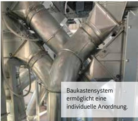
Baukastensystem ermöglicht eine individuelle Anordnung.
