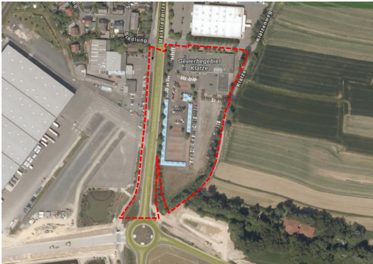
Abbildung 3: Luftbild (Bild genordet, unmaßstäblich; ergänzt um rote Abgrenzung des Plangebiets)
