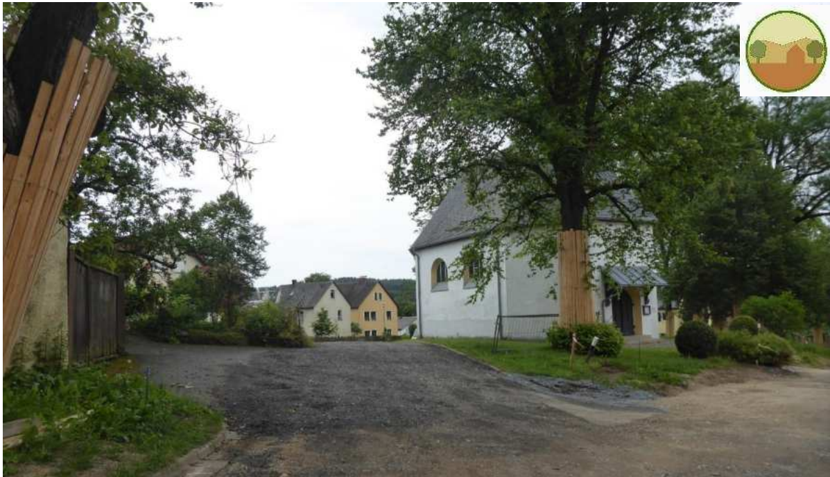
Abb. 27: Schutz und Erhalt wertgebender Vegetation in Poppenreuth während innerörtlichen Baumaßnahmen (TBM, 2025)
