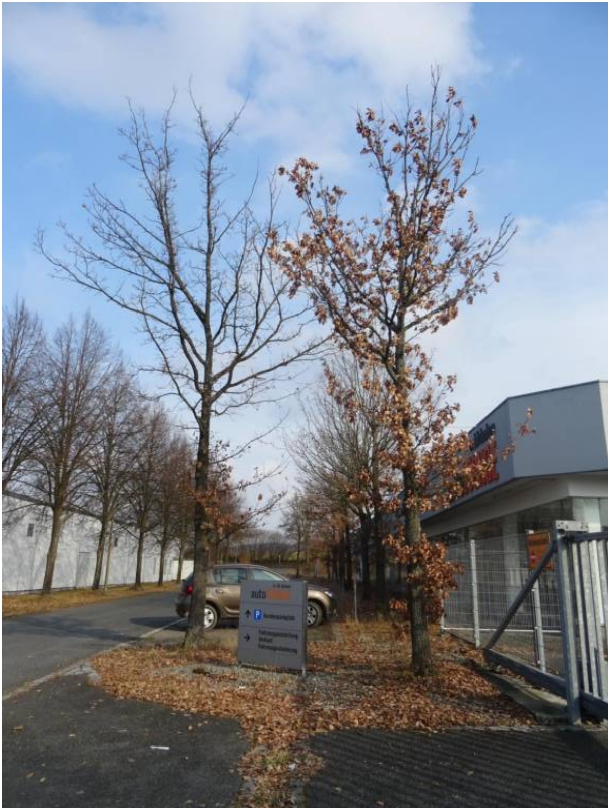
Abbildung 8: Eingangsbereich der ehemaligen "Auto Lounge" im Nordwesten der BBP-Fläche
